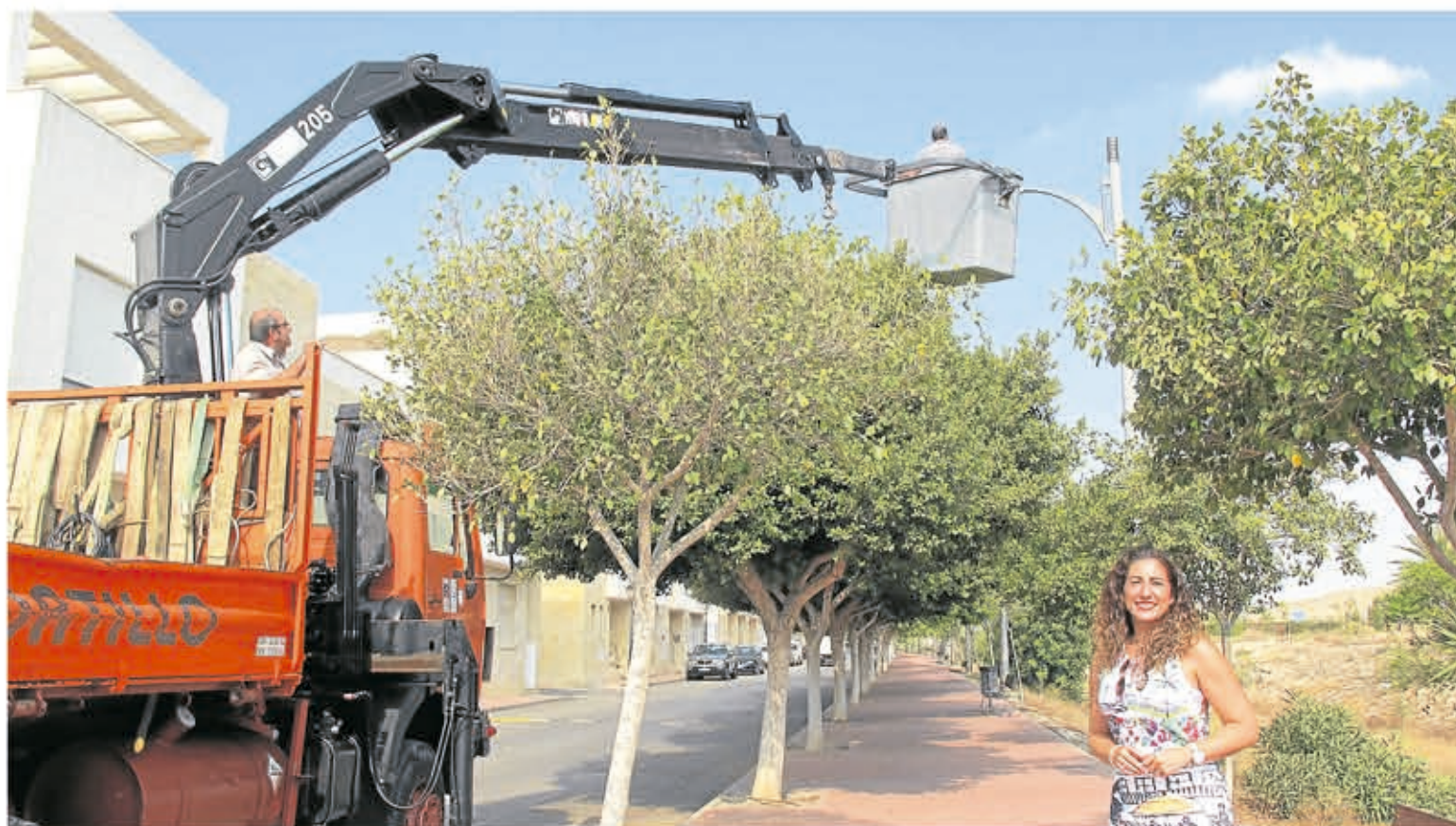
La concejal de Obras, Belén Carnicer, comprueba los trabajos de instalación de las nuevas farolas en el centro urbano de Vera.
