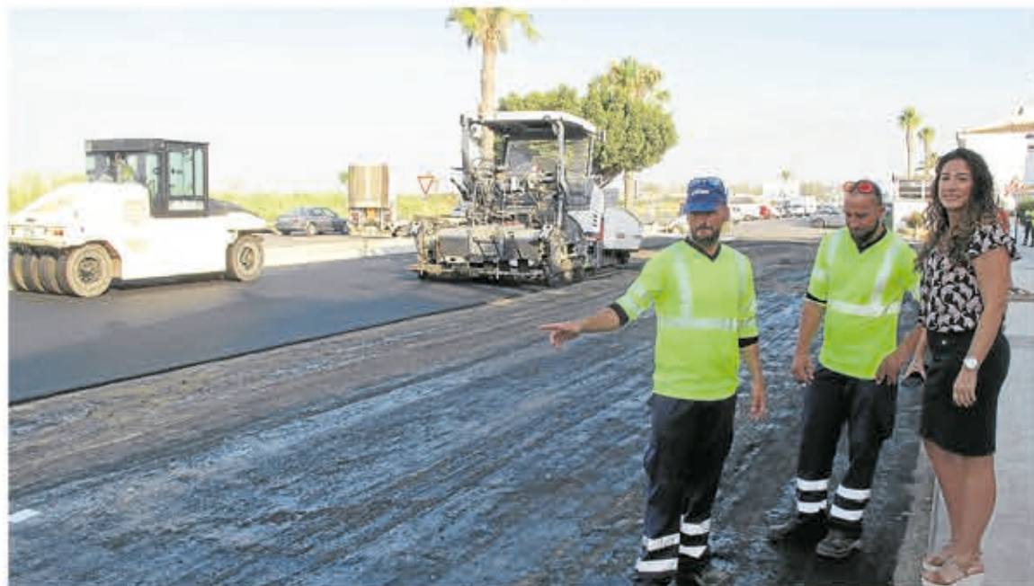
La concejal de Obras, Belén Carnicer, visitó las obras de mejora del firme en Las Bugarvillas.
