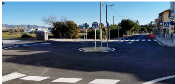
Obra ya terminada
