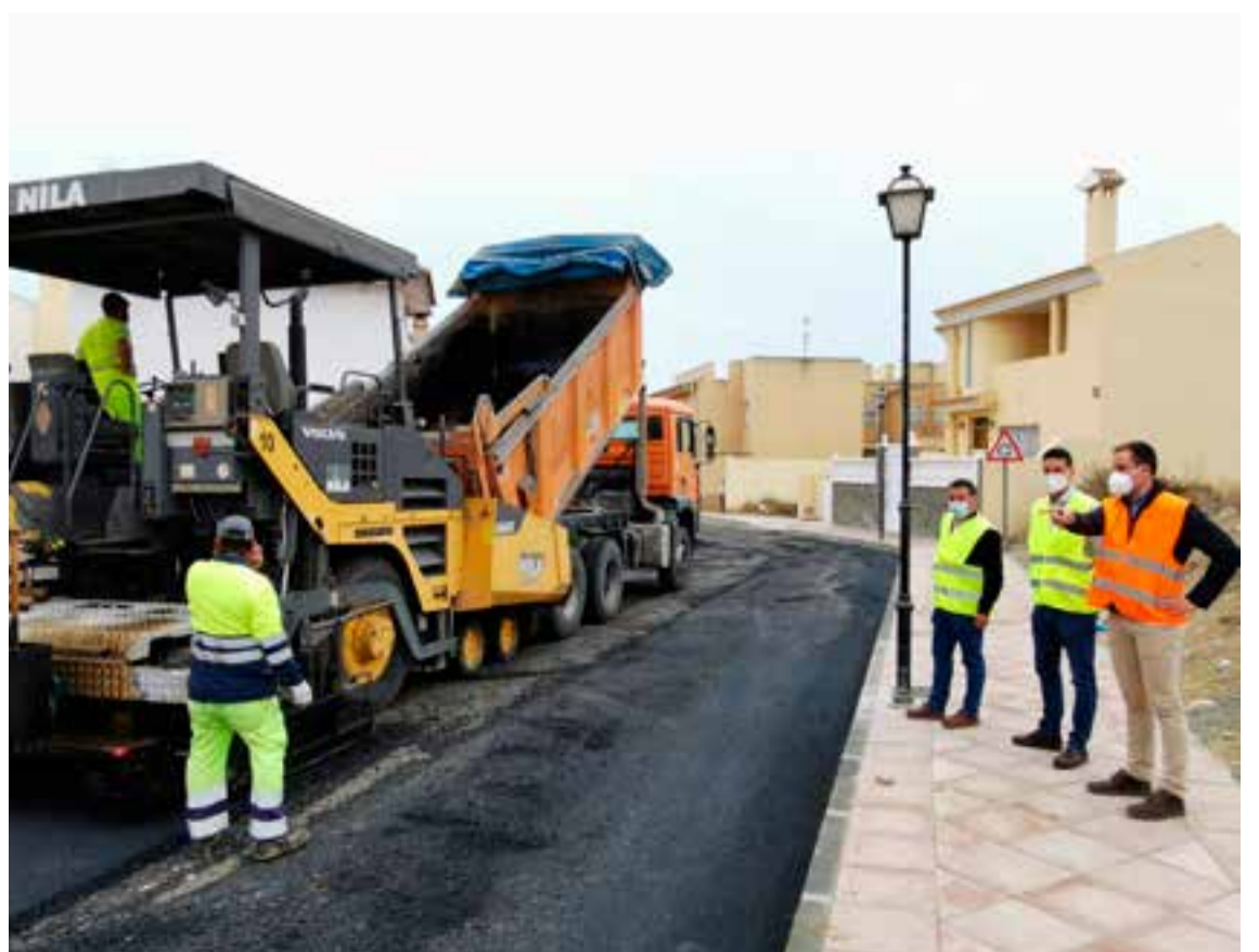
Alfonso García, concejal de Infraestructuras supervisando los trabajos
