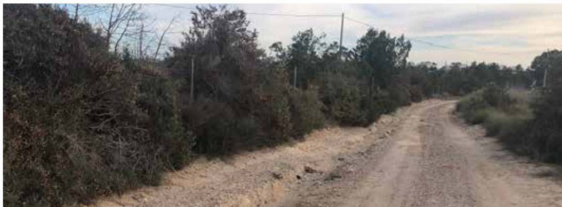
Estado actual del “Camino de Pescadores”
