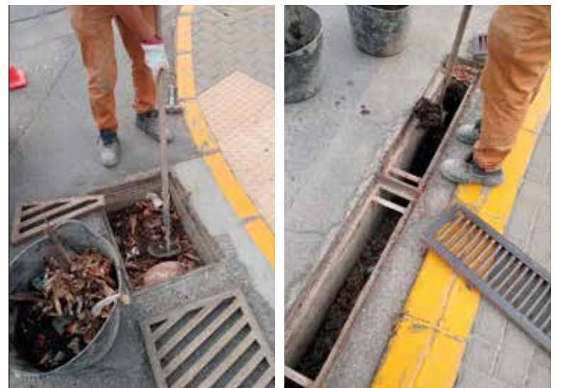
Operarios retirando maleza de imbornales
